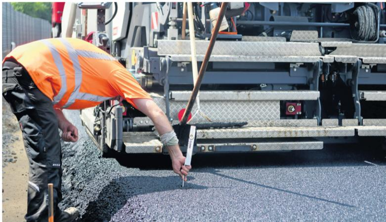
**Drei Zentimeter Dicke soll die Verschleißschicht haben. Gesamtgefälle der Asphaltdecke: etwa zwei Prozent – für den Abfluss des Regenwassers.**
