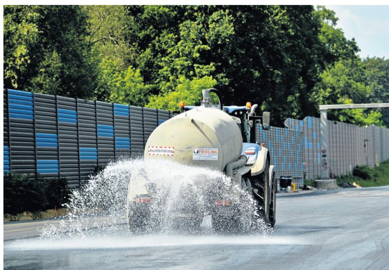
**Der frisch aufgetragene Asphalt wird ausgiebig gewässert, denn sonst würde durch die Hitze der Kleber an Haftkraft für die nächste Schicht verlieren.**
