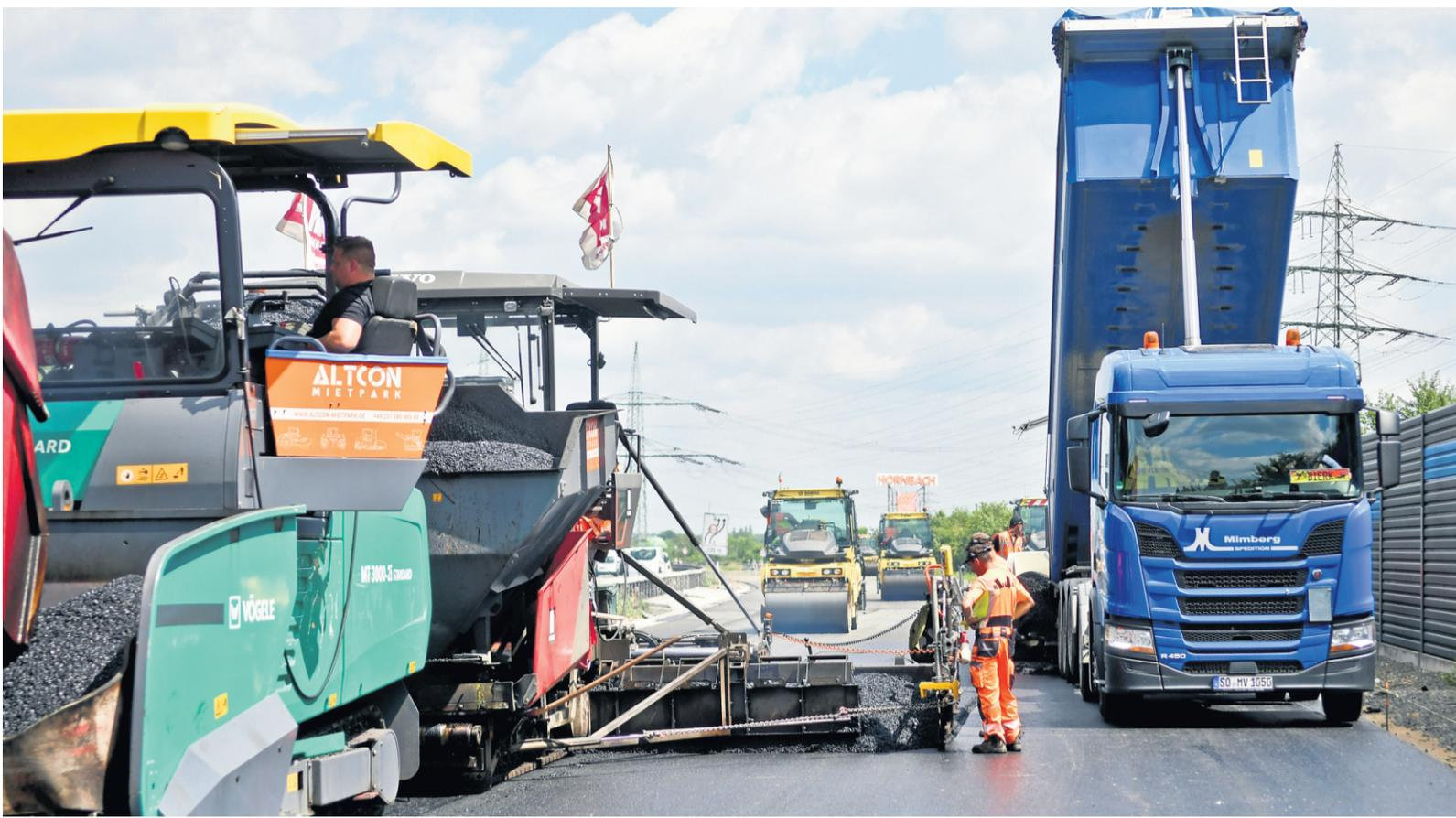
Tonnenschweres Ballett: Lkw, Beschicker, Apshaltfertiger und Walzen bilden eine aufeinander abgestimmte Einheit. FOTO: HEINRICH JUNG / FUNKE FOTO SERVICES
